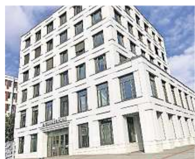
Blick auf das Erkelenzer Amtsgericht.
